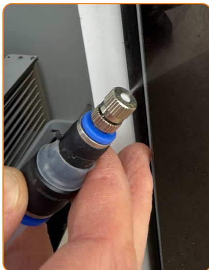
Рисунок 6.12 – Работающая форсунка.
